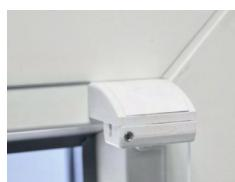
5. При наличии у модели подоконных кронштейнов установить пару кронштейнов на штапик с опорой (правый и левый). Кронштейн присверлить в угол штапика или на раму одним шурупом 2,9\*9,5 и одним 2,9 \*13 (входят в комплект креплений).
