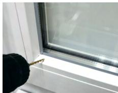
5. Сверлом диаметром 2,5 мм просверлить отверстие в нижнем штапе (для фикс. лески).
