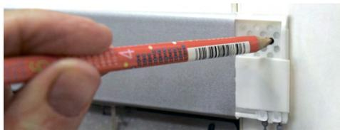
4. Прислонить карниз к створке и прикрепить изделие одним саморезом с каждой стороны (выбор самореза зависит от глубины штапика и кол-ва подкладочных плиток).
