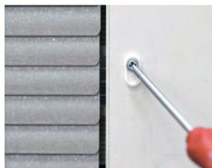
9. С помощью самореза прикрутить на раму держатель цепи управления.
